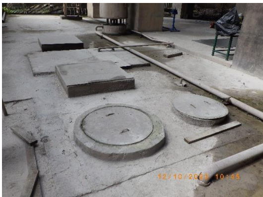
รูปที่ 2-13 บ่อพักน้ำ Blow Down ใต้ SP Boiler
