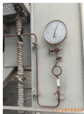
รูปที่ 2-45 Pressure gauge ของหม้อไอน้ำ
