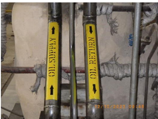
รูปที่ 2-56 ระบบท่อน้ำมันเลี้ยงเบรค ของ Turbine & Generator
