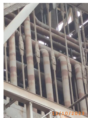
รูปที่ 2-47 Rapid Drain Piping System ของหม้อไอน้ำ
