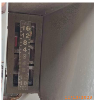
รูปที่ 2-46 เครื่องวัดระดับน้ำ ของหม้อไอน้ำ
