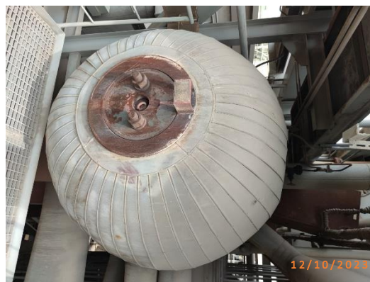
รูปที่ 2-43 Steam Drum ของหม้อไอน้ำ
