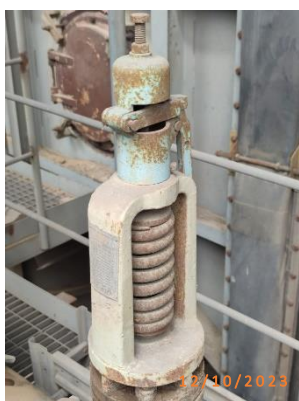
รูปที่ 2-44 Safety Valve ของหม้อไอน้ำ
