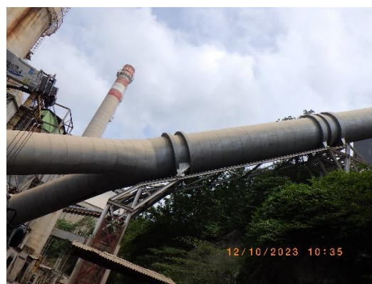
รูปที่ 2-33 ท่อลำเลียงลมร้อนออกจาก SP Boiler ในระบบปิด
